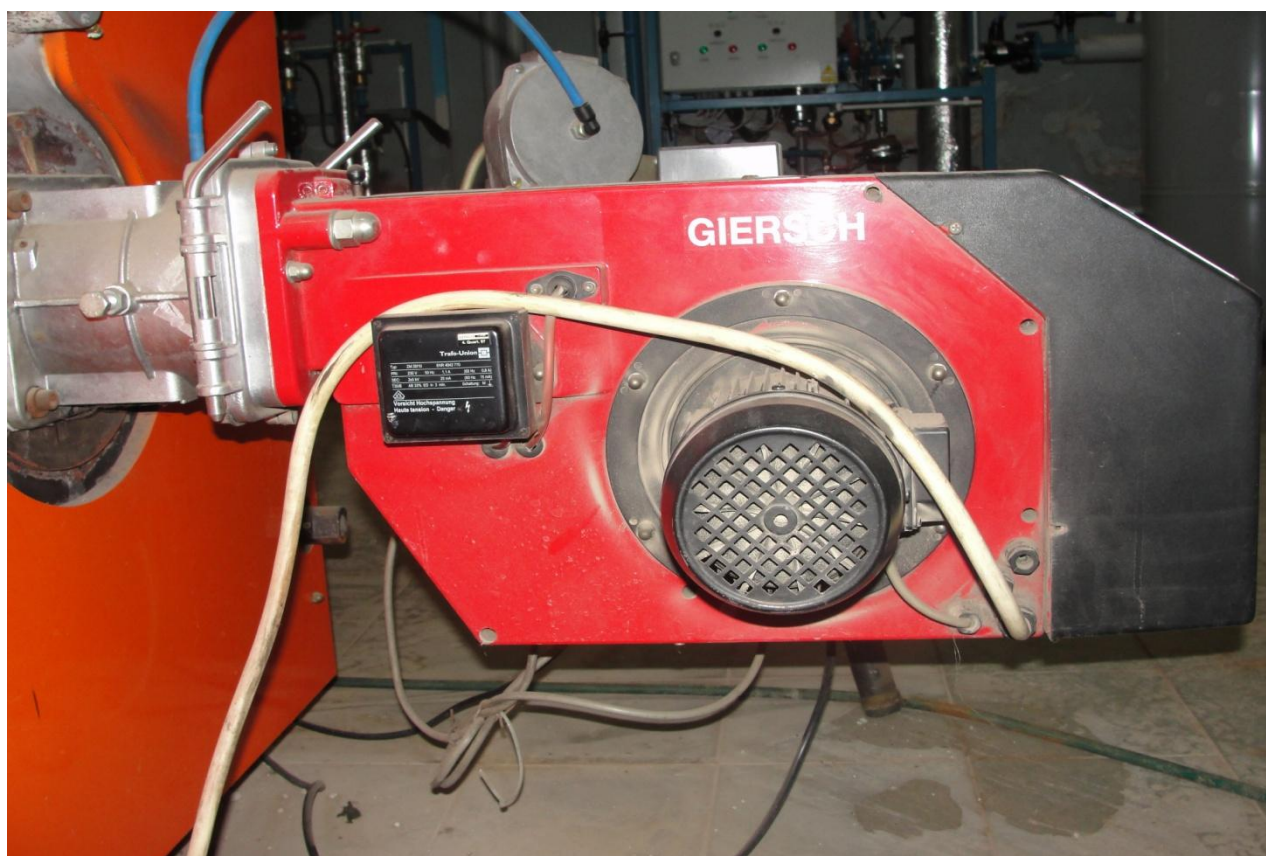
Zdjęcie nr 4 - widok boczny palnika
